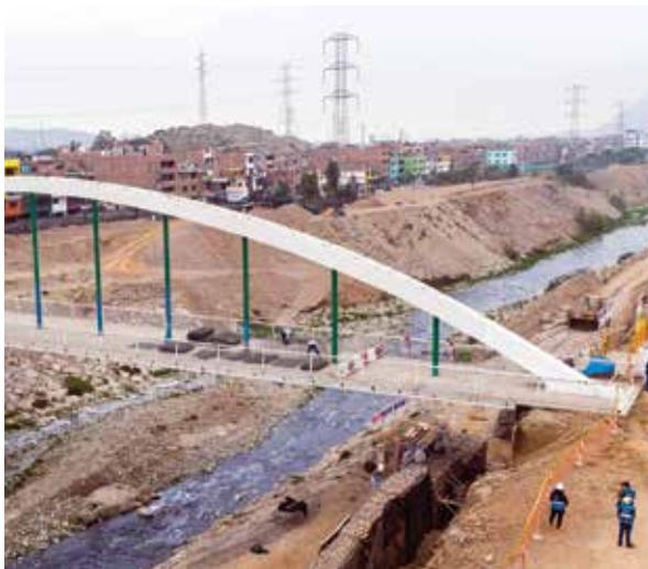
La estructura se apoya en estribos de concreto armado con cimentación profunda mediante pilotes preexcavados de 14 m de longitud con aletas en vuelta para sostener la caída de tierras.
