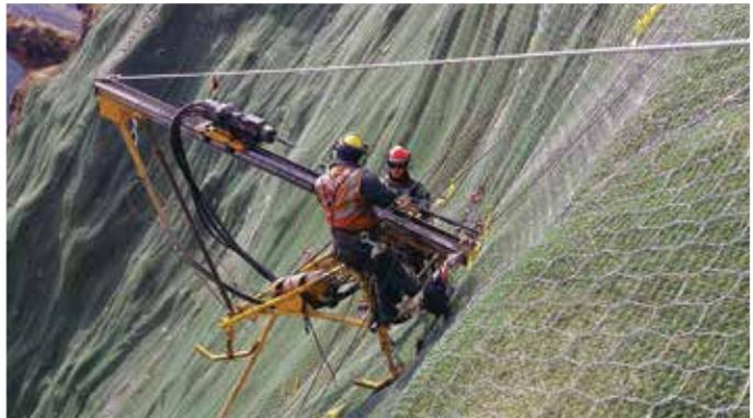
Protección de Talud con Mallas e Instalación de Geomanta MacMat R.
