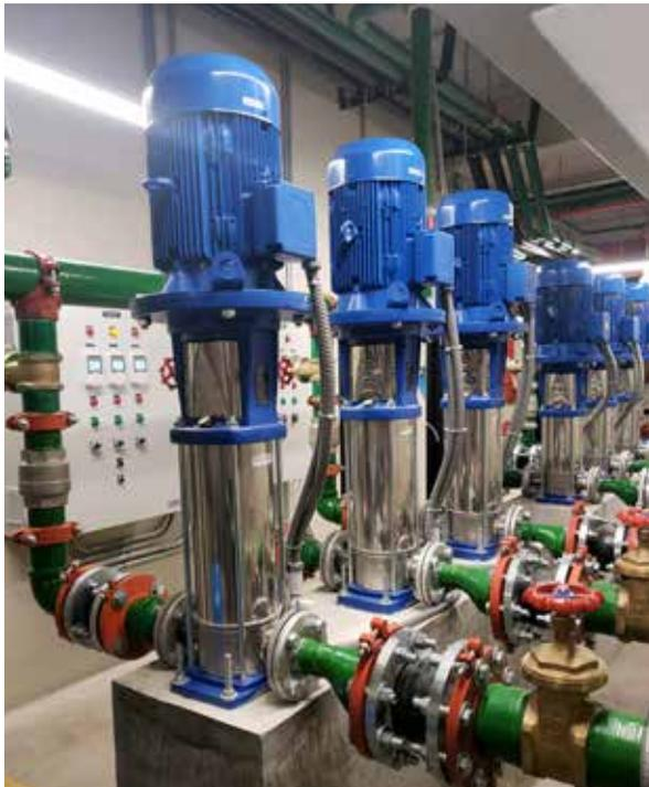
Para este tipo de instalaciones se debe realizar un correcto dimensionamiento en los diámetros de succión y descarga de las bombas para evitar futuros problemas.
