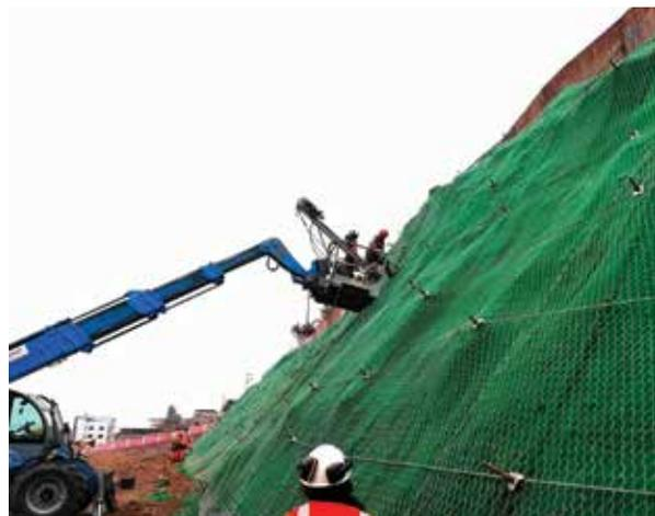
Estabilización de Taludes con sistema de mallas y pernos.
