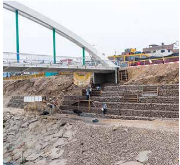
Se ejecutaron trabajos de enrocado de protección y defensas ribereñas que contempló la ejecución de 125 metros lineales aguas arriba y abajo del eje del puente.
