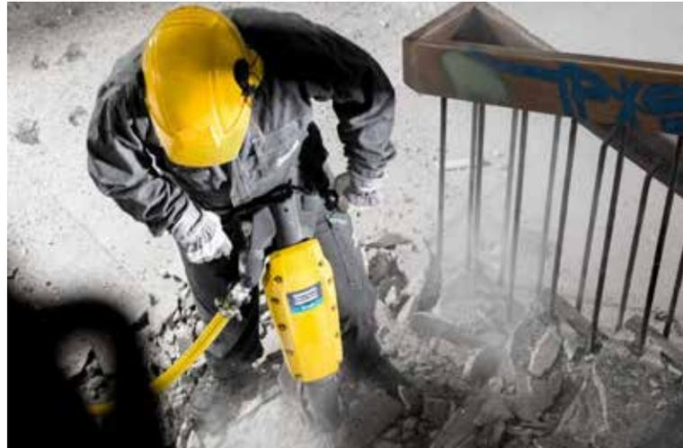
Debido al constante contacto que tiene esta herramienta con la superficie a demoler, la punta se desgasta, siendo reemplazada rápidamente.
