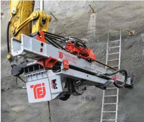
Soil Nailing empleando el Sistema de Barra Auto perforante.
