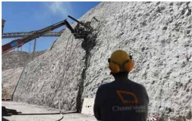
Desnivel ofrece los sistemas flexibles de estabilización mediante distintos tipos membranas de alambre y anclajes según la tipología del terreno y facilidad de acceso para maquinaria
