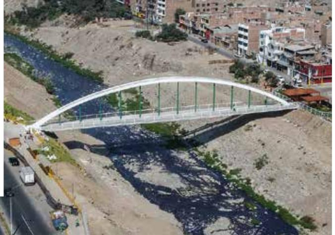
Los estribos se definen mediante una silla cargadero de concreto armado con aletas en vuelta, con cimentación profunda por medio de 2 pilotes de 1,20 m de diámetro y 14 m de longitud. En la parte central de la silla cargadero se aloja una ménsula metálica unida a la superestructura que sirve como tope sísmico.
